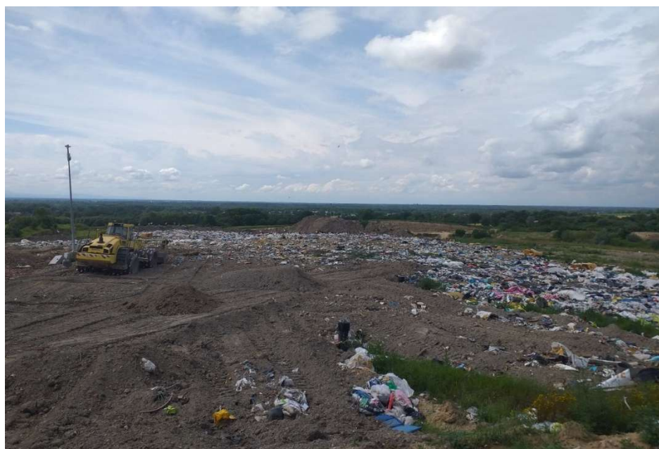
Vue des casiers W5 - W6
