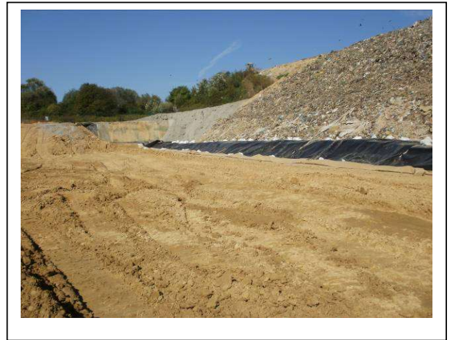
Début de terrassement pour créer W4
