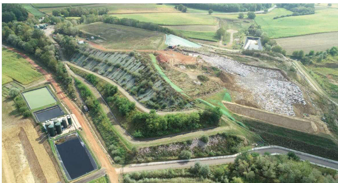
Photo aérienne depuis le secteur Nord-Ouest de l'ISDND avec vue sur la station de traitement des lixiviats à gauche et les casiers à droite (source SMICTOM)
