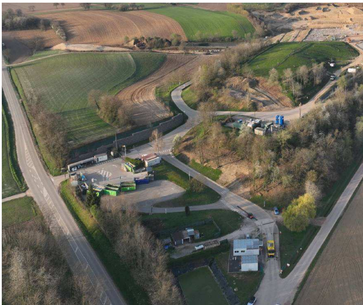
Photo aérienne depuis le secteur Nord-Est de l'ISDND avec vue sur toutes les unités du site sauf la station de traitement (production ATIP, source SMICTOM)
