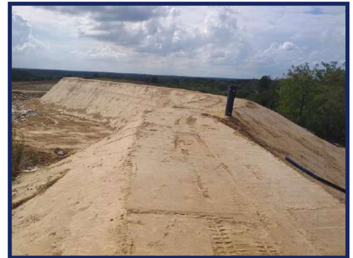
ISDND : rehausse de la digue W5 et W6
