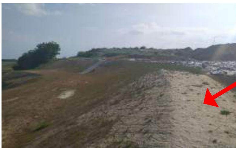
Digue périphérique de W6.
