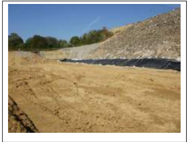
Début de terrassement pour créer W4
