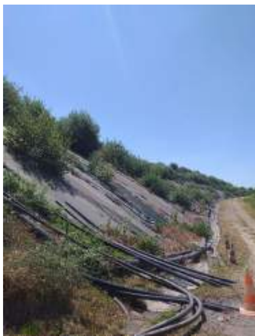
Wintzenbach 2 – couverture provisoire
