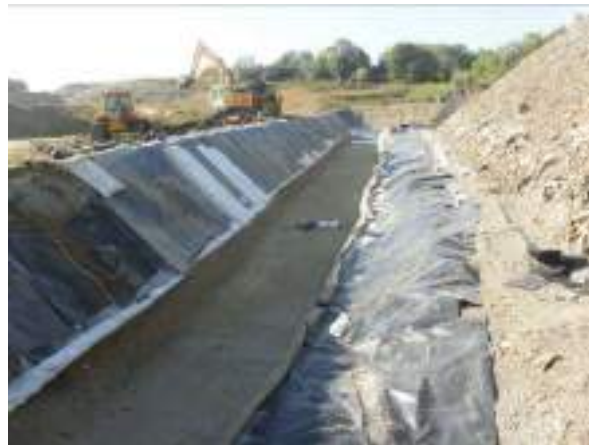
Extraction des déchets pour mise en conformité du flanc entre W3 et W4
