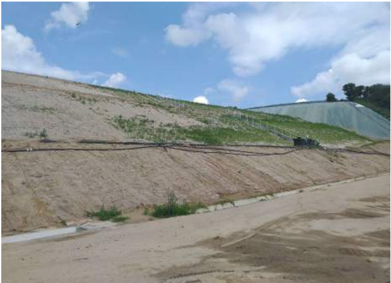
Vue du chantier W3-W4
