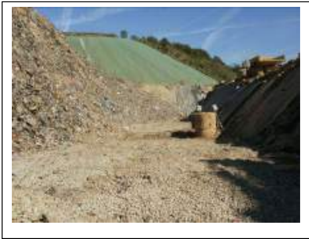
Evacuation des déchets le long de la plate-forme enrobée
