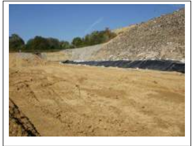
Début de terrassement pour créer W4
