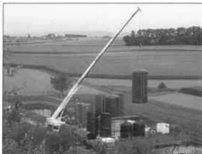
Mise en place des nouvelles cuves en fibre
