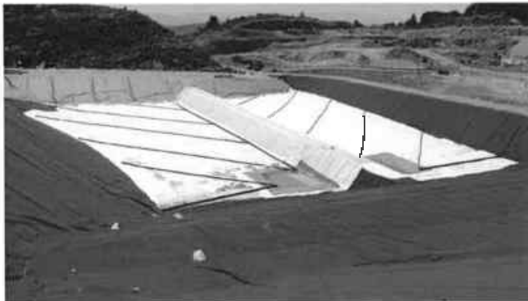
Vue générale des drains au fond – avant la pose des matériaux drainants
