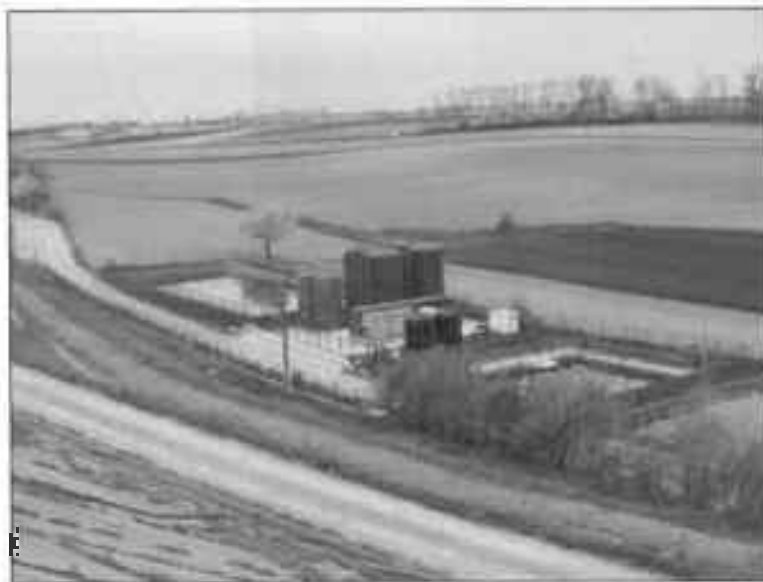
Vue générale de la station de traitement.
