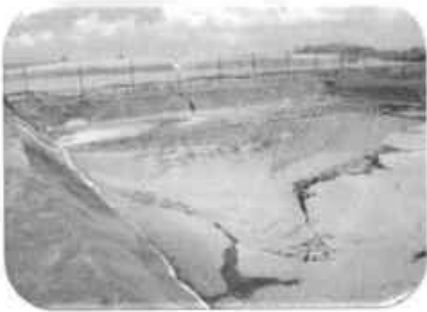
Bassin Lixiviats bruts
