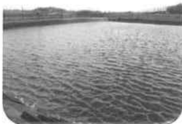
Bassin de Ruissellement Ouest 2
